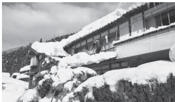
1メートル以上積もった屋根の雪下ろし作業。2/4 波賀町北部にて
