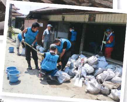
床下に入り込み、 薄く積もった泥をかき出すボランティア
