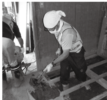
床下に溜まった泥を手作業で取っていきます
