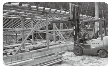
新しい牛舎を建設中。 自分で建てておられます
