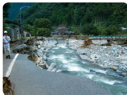
台風9号豪雨災害で崩落した県道一宮生野線と津羅橋(21.8.10 福知)
