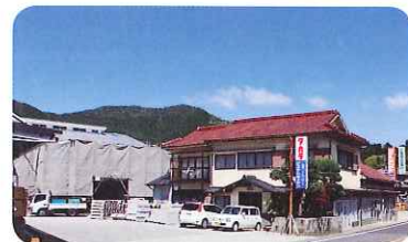
現在の店舗の奥に住まいを兼ねた 新しい社屋を建設中
