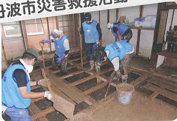
家屋内の泥あげ作業(市島町内)
