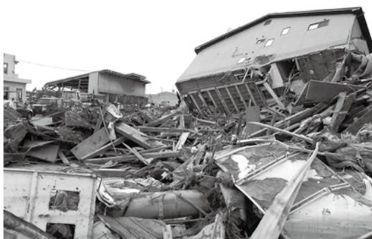
巨大津波で瓦礫の山と化した住宅地 (宮城県岩沼市)
